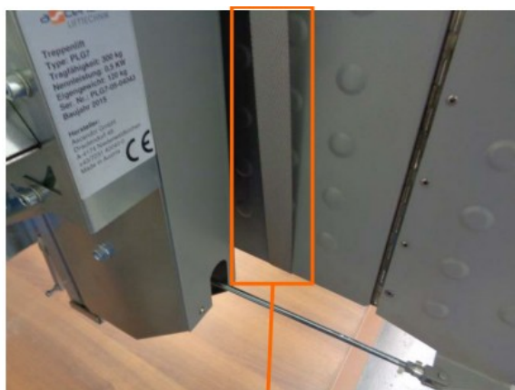
Napněte napínací popruh mezi plošinou a závitovou tyčí
